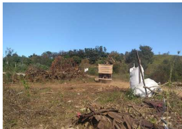
Foto 4 – Colaborador realizando supressão (Registro fotográfico 04/06/2022).
