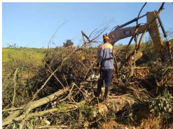
Foto 11 – Parcela 15 supressão realizada (Registro fotográfico 09/07/2022).
