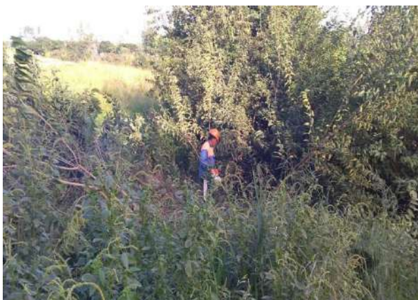
Foto 3 – Parcela 01 supressão realizada (Registro fotográfico 04/06/2022).
