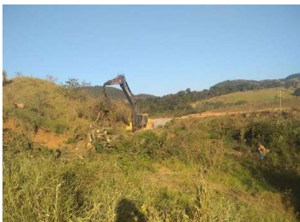
Foto 13 – Escavadeira realizando retirada de material suprimido (Registro fotográfico 18/07/2022).
