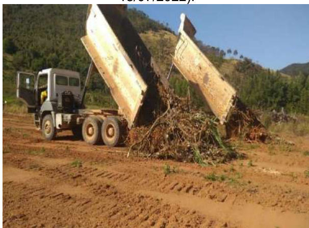
Foto 15 – Material transportado ao pátio de toras(Registro fotográfico 20/07/2022).
