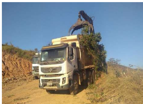
Foto 14 – Material Suprimido sendo enviado para o pátio 01 (Registro fotográfico 19/07/2022).
