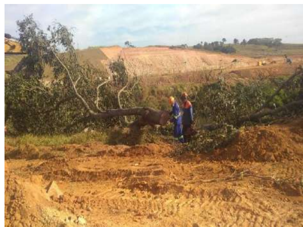
Foto 12 – Colaborador realizando supressão (Registro fotográfico 15/07/2022).
