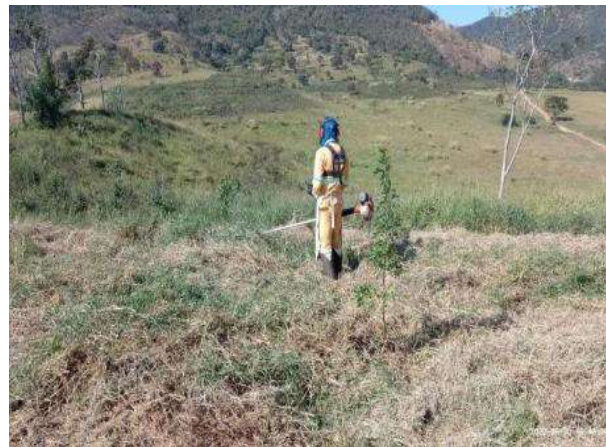
Foto 2 – Avanço da equipe de roçada (Registro fotográfico 06/06/2022).
